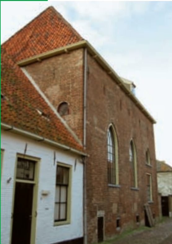
De voormalige synagoge van Elburg
