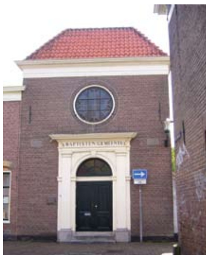
De voorgevel van de synagoge. Links en rechts van de ingangspartij zijn stenen met Hebreeuwse inschriften zichtbaar.
